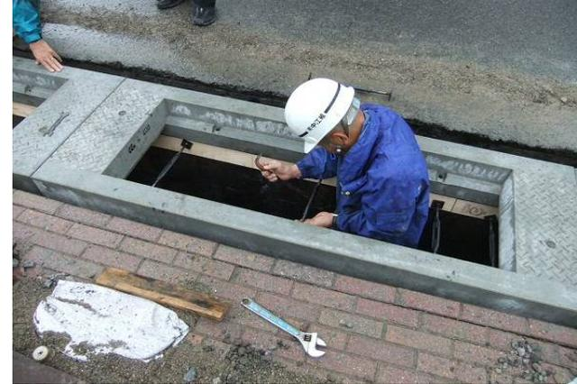
4. 既設側溝と製品の隙間に型枠をセットします。
