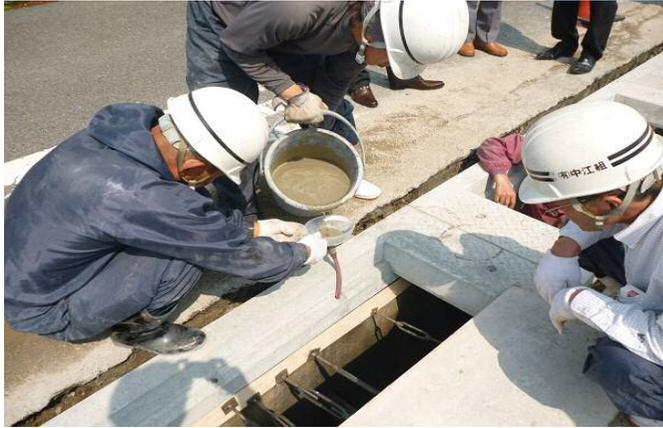
5. 蓋掛り面に設けられた注入孔より高流動性無収縮モルタルを注入します。注入は下流より行ないます。
