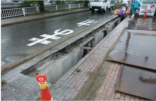
1. 既設の現場打ち側溝上部を製品厚+2cm位、カットとハツリにより除去します。高さが確保されていれば、ハツリ面のままですら問題ありません。
