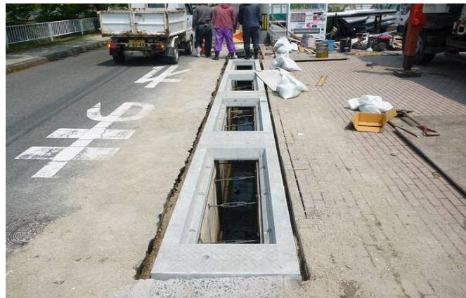
7. 養生期間を1日とった後、型枠を撤去し、製品上部のアジャスターボルト部をモルタルで埋める。
