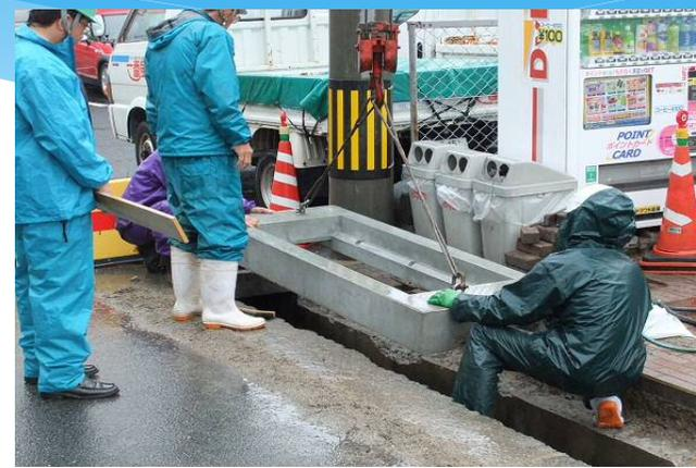
2. 上部を除去した既設側溝の上にCRスラブⅡ型をセットします。この時あらかじめアジャスターボルトを製品上部4隅にあるインサートに取り付け、製品下部より2cm位突出させておきます。
