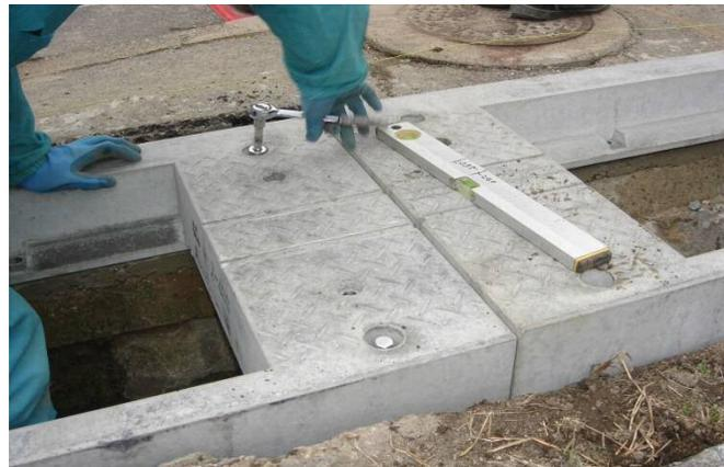
3. 水平器を見ながら製品上部よりアジャスターボルトで高さの調整を行ないます。
