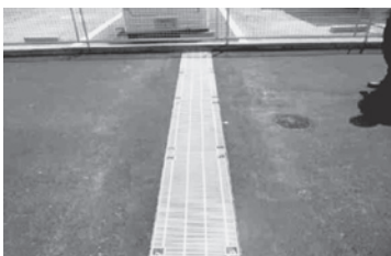
かたんグレーチングⅠ型 (早期施工用) 埋戻し材：無収縮モルタル +アスファルト
