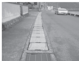
智頭町：町道本折南方線側溝修繕工事
