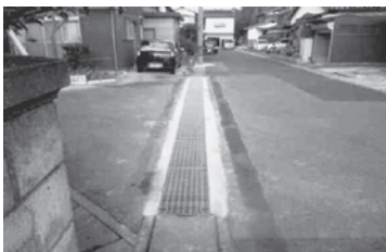
かたんグレーチングⅡ型 (通常施工用) 埋戻し材：コンクリート
