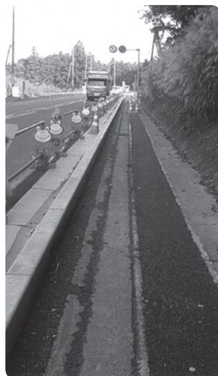
▼施工中 (アスファルト施工)
