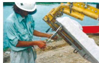
らくピタ(高さ調整ボルト)設置状況
