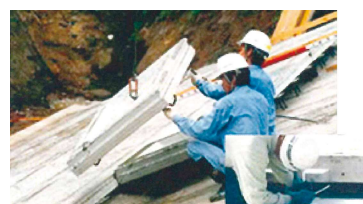
大型張りブロック据付状況 らくピタ(高さ固定ボルト)調整中
