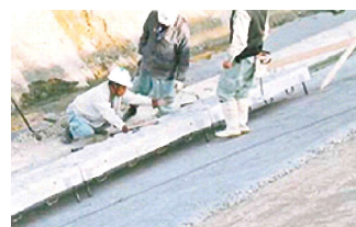
大型張りブロック据付状況らくピタ調整後
