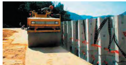
重機による壁面近傍の転圧状況
