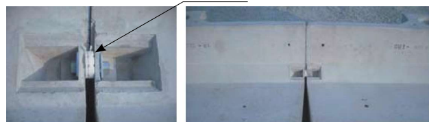
※曲線部は専用プレートにて連結します。
