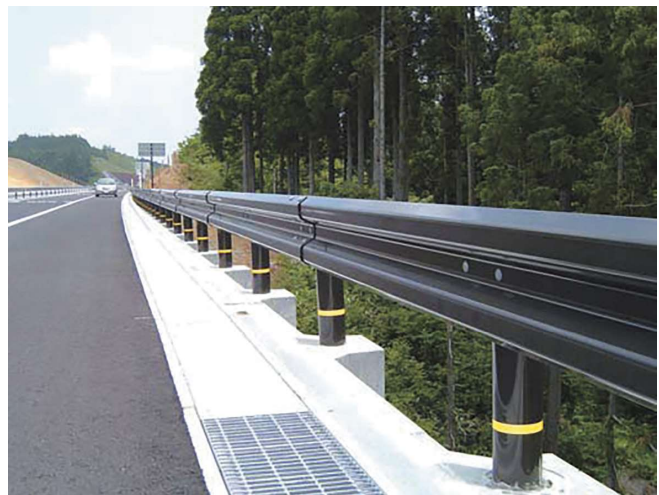
背面に側溝設置の事例
