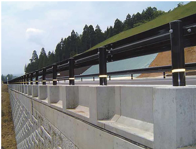
補強土壁直上設置の事例
