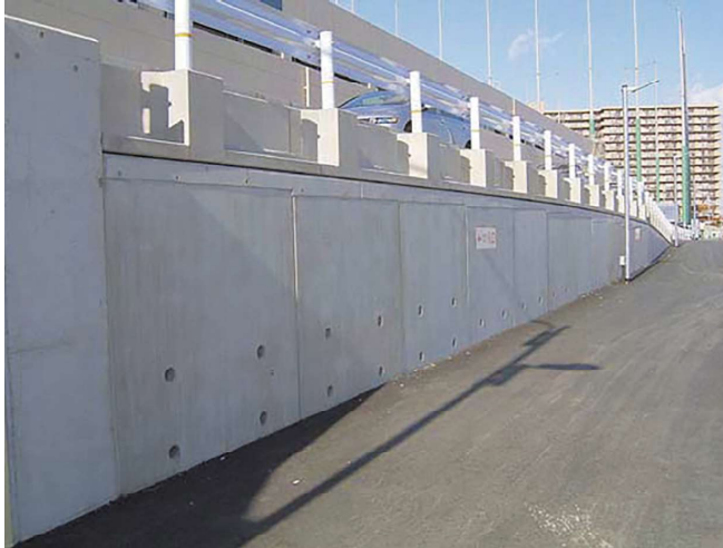
プレキャストL型擁壁直上設置の事例
