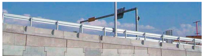
縦断勾配9%の施工実績例
