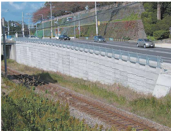
超軽量盛土直上設置の事例
