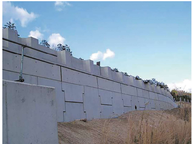
補強土壁直上設置の事例
