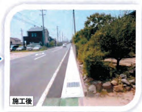
西部総合事務所：県道大篠津停車場線側溝修繕工事（地方特定）
