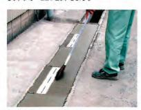
刷毛引き刷毛引きをして仕上げ、養生します。
