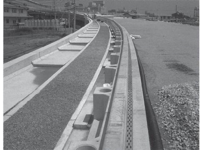
特殊施工例 — 歩車道境界部への利用
