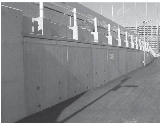
プレキャストL型擁壁直上
