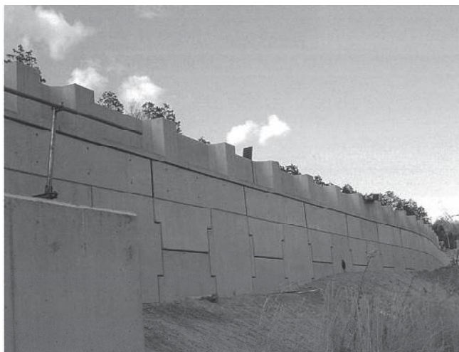
補強土壁直上
