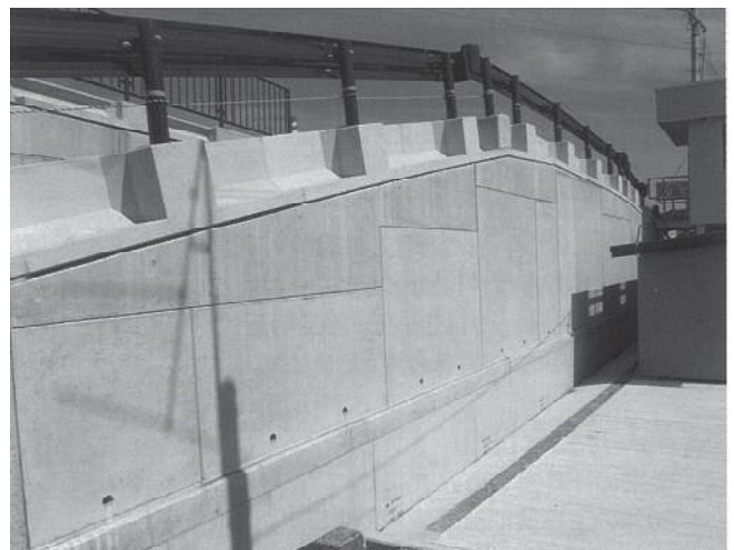
急激勾配変化部（超軽量盛土上）
