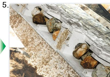
5. 背面開口部に吸出防止材を敷設し裏材を埋め戻し、衝撃を与えないよう石材・土砂等の中詰材を充填します。
