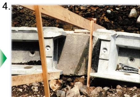
4. 曲率半径が小さい場合は開き部に現場打コンクリートを打設します。
