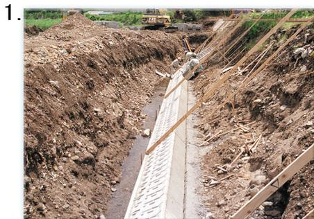
1. 床掘・基面製正・基礎コンクリート打設を行います。
